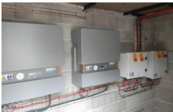
Onduleurs CEFEM TRIO TOP 18 KW
